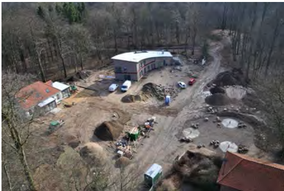
Blick auf die Baustelle vom Fernsehturm aus
